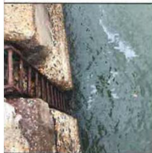
Figuur 3 - 7: schadebeeld kaaimuur Bron: BASF Antwerpen
